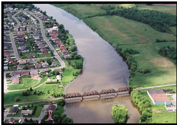
Prise d'eau de Casselman (Rivière Nation Sud)
