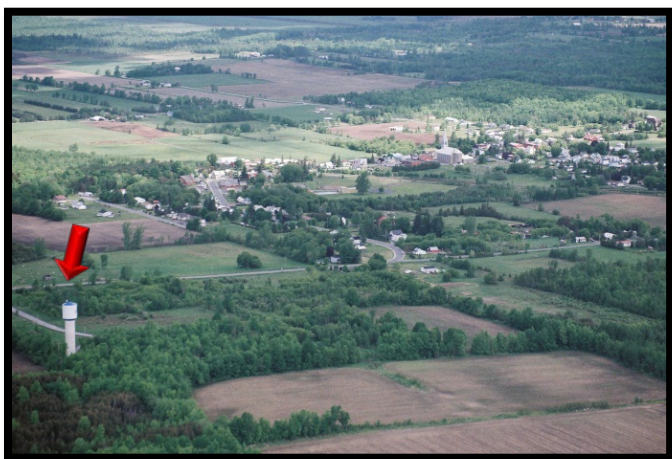
Têtes de puits de Moose Creek
